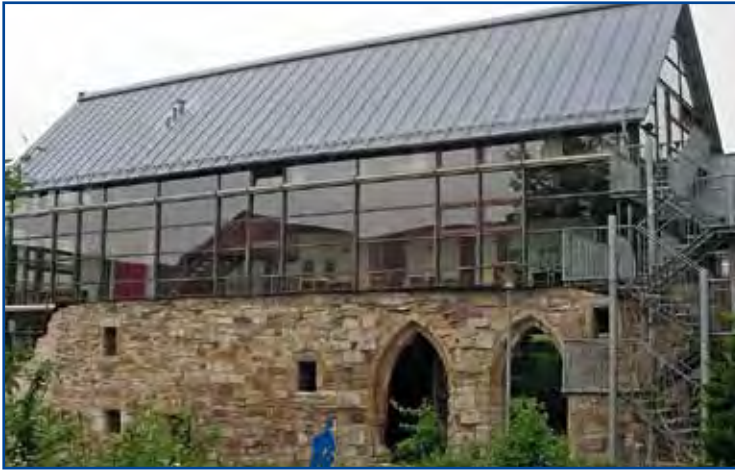
Neubau der Konventsgebäude
